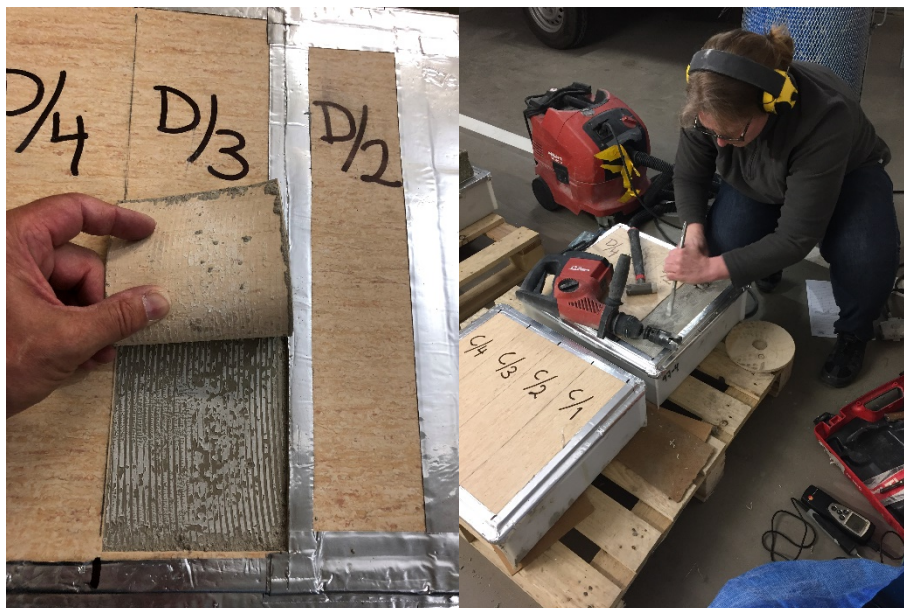
Fig. 3 Undersökningsmoment. Vänster - avlägsnande och inspektion av ytskikt, höger provtagning för RF-mätning i avjämning.
